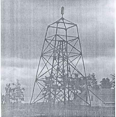
Геодезический пункт - инженерная конструкция, закрепляющая точку земной поверхности с определенными координатами.
